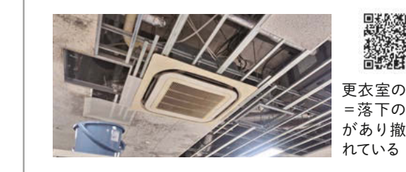
更衣室の天井 = 落下の危険があり撤去されている
