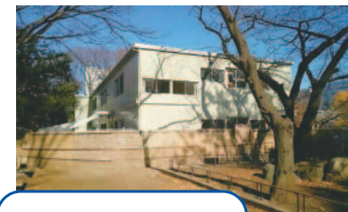
礪川公園内の園舎。 4月からは認可外の 臨時保育園として、 3年間運営します。
